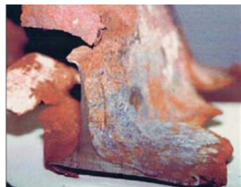
Détail d'une poutre d'acier érodée
