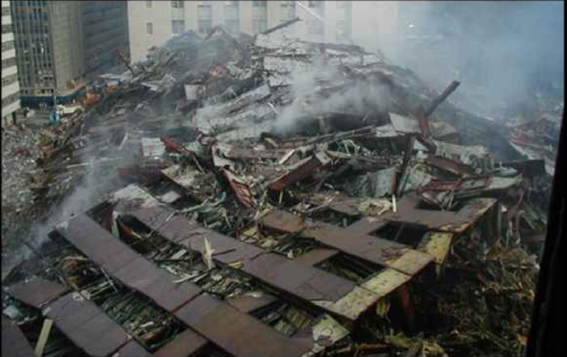
Indiquant un total démembrement de la structure d'acier et pulvérisation de l'essentiel du béton
